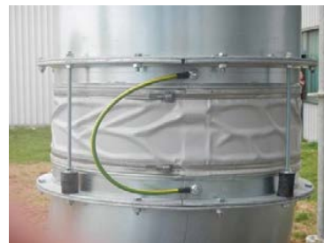
Abb. 31 Kompensator in einer Absauganlage
